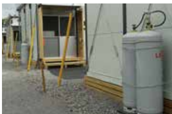
仮設住宅に設置したLPガス容器
