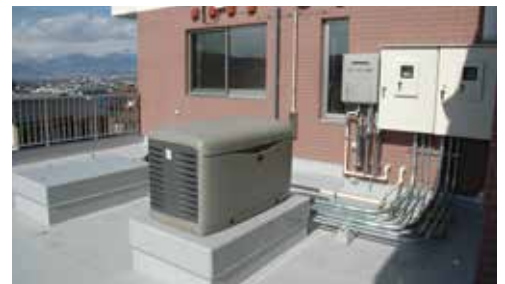
非常用LPガス発電機
