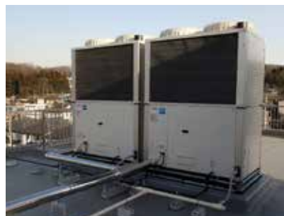
屋上に設置したGHP
