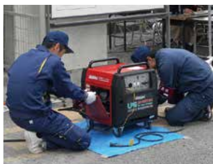
LPガス低圧発電機の稼働訓練
