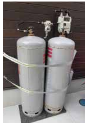
LPガスの軒下在庫
