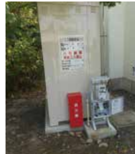
深谷市立小中学校全校に設置した災害時対応ユニット
