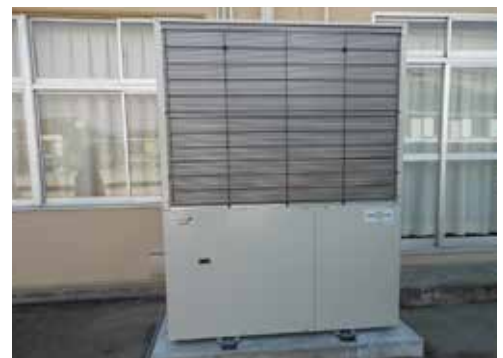
笛吹市の小学校に設置したGHP
