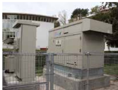
非常用LPガス発電機
