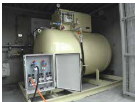
容器庫内に設置した災害対応バルク貯槽
