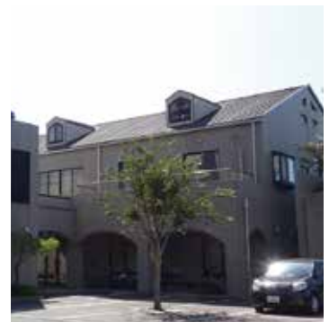
LPガスGHPを設置した カトリック習志野教会信徒会館
