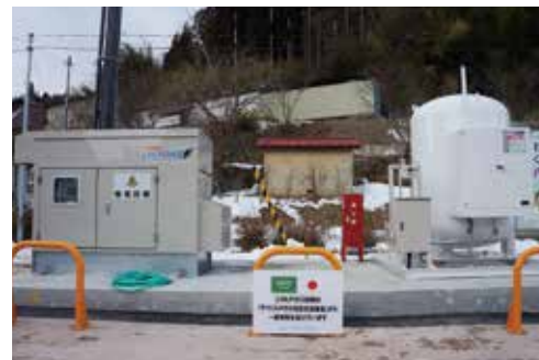
非常用LPガス発電機と災害対応バルク貯槽
