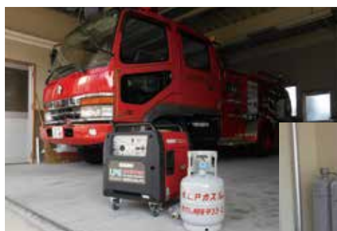
消防本部拠点に設置した非常用発電機
