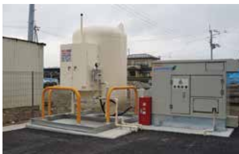
災害対応バルク貯槽と非常用発電機
