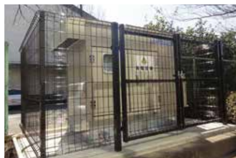
非常用発電機
