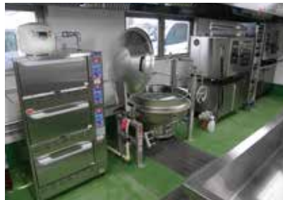
LPガス調理機器が並ぶ厨房
