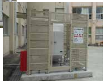
バルク貯槽と災害時ユニット
