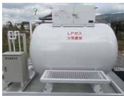
災害対応バルク貯槽とガス栓BOX
