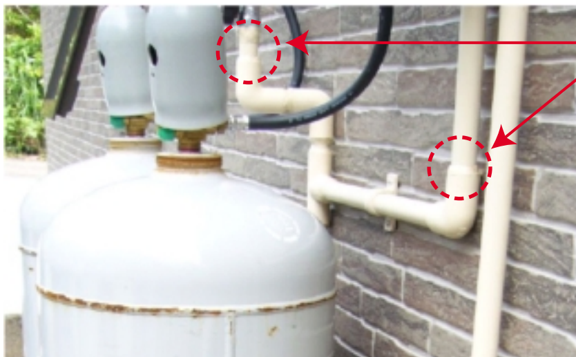
パテによる余ねじ部の保護を施した例
