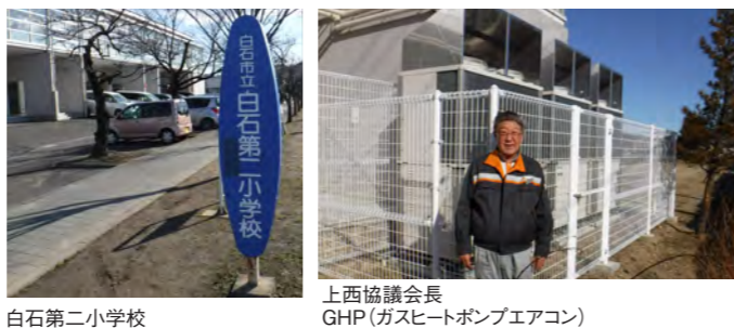
白石第二小学校 上西協議会長 GHP(ガスヒートポンプエアコン)
