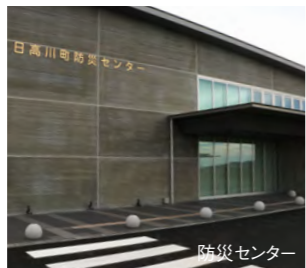
防災センター
