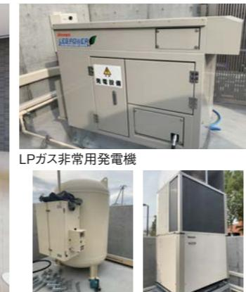
LPガス災害バルクとGHP(ガスヒートポンプエアコン)
