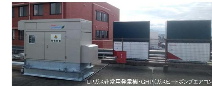
LPガス非常用発電機・GHP(ガスヒートポンプエアコン)
